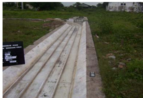
Gambar12. Hasil flushing pada tengah saluran Colo timur
