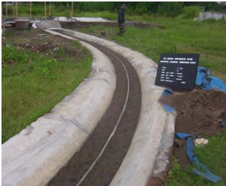
Gambar 7. Penghamparan bahan sedimen pasir kali
