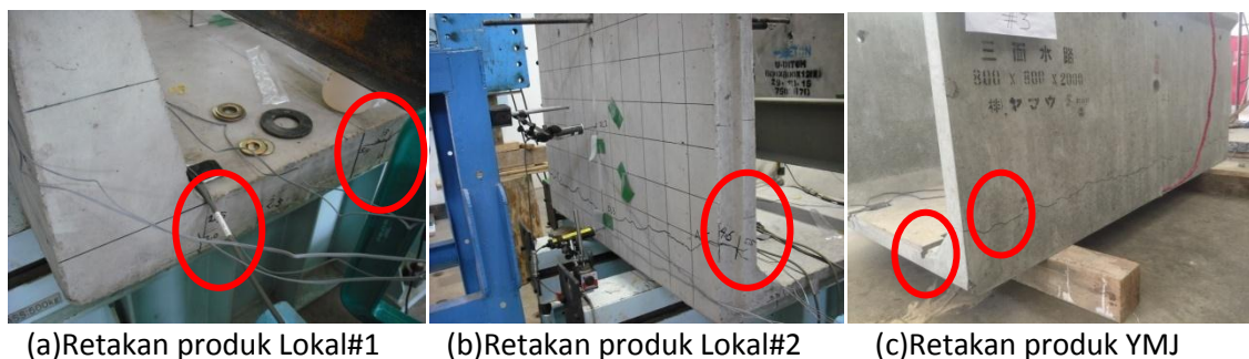
Gambar 9. Lokasi Retakan yang Terjadi
