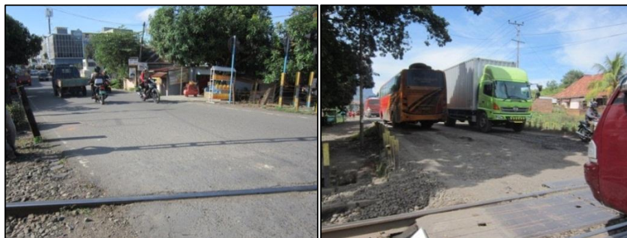
Gambar 2. JPL 126 di KM 396+666 Lebar 4 Meter (Jalan Kabupaten) dan JPL 139 (KM 420+825)Lebar 8 Meter (Jalan Provinsi)
