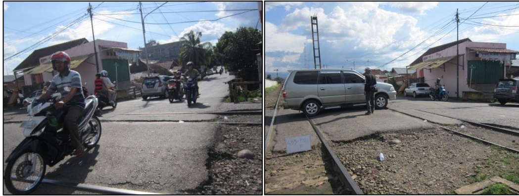
Gambar 7. JPL 150 (KM 433+717) Lebar 6 Meter (Jalan Kabupaten) di dalam Wilayah Emplasemen Stasiun Lahat
