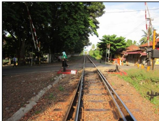
Gambar 6. Posisi Wesel di Perlintasan JPL 124 (KM 396+276)
