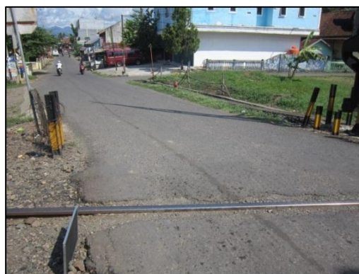
Gambar 4. JPL 147 (KM 432+268) Lebar 6 Meter (Jalan Kabupaten)
