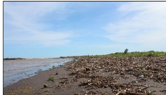
Gambar 3. Bangunan Pemecah Ombak di Pantai Trisik, Kulonprogo
