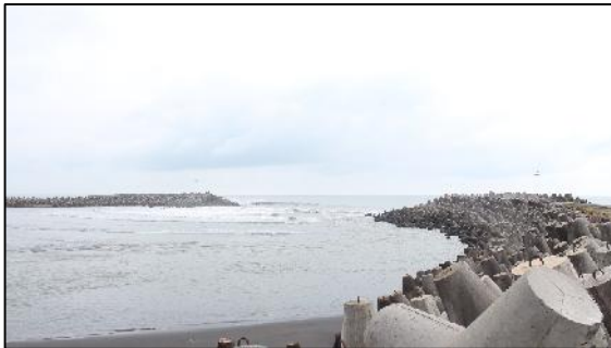
Gambar 2. Bangunan Pemecah Ombak di Pantai Glagah, Kulonprogo
