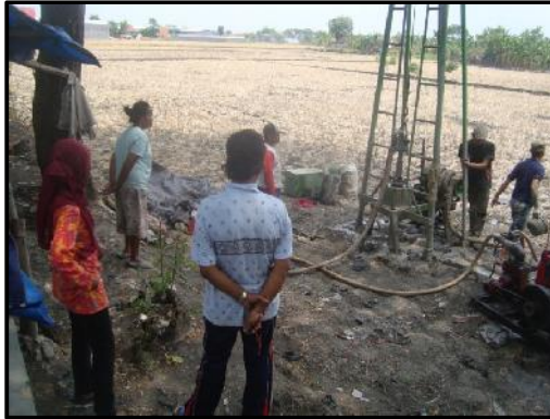
Gambar 2. Pembuatan Sumur Bor di Desa Boloh Kecamatan Toroh
