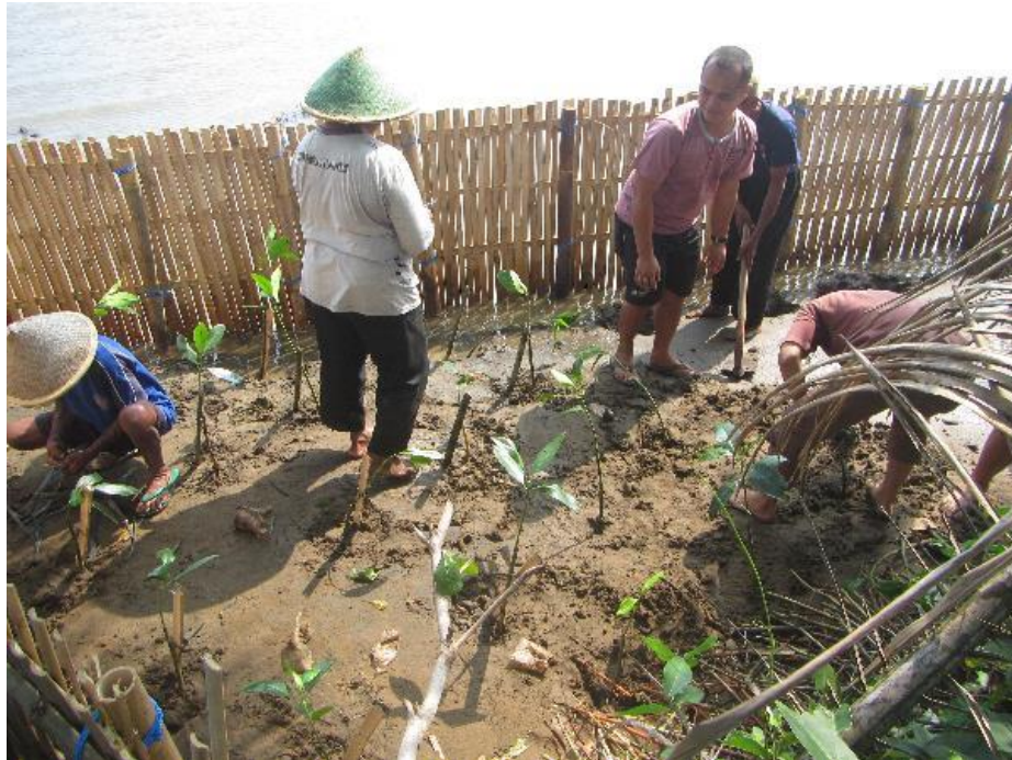
Gambar masyarakat Desa Jangkaran bergotong-royong menanam bibit mangrove di lokasi yang telah dipasang penahan ombak dari bambu.
