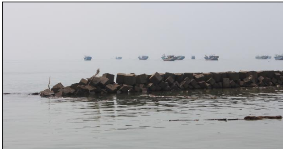
Gambar 4. Penahan abrasi dengan bangunan pantai model kubus Sumber: Mahendra, 2016
