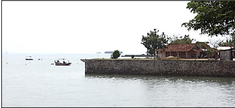
Gambar 5. Penahan abrasi dengan talud
