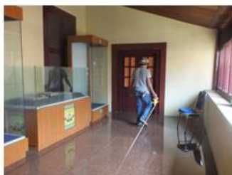
Lantai baru Granit
