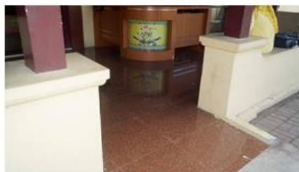
Lantai baru Granit
