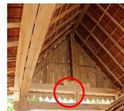
Gambar 11. Konstruksi dengan sistem tanding tanpa paku (Sumber: Penulis, 2017)
