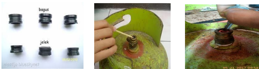
Gambar 1. Kondisi seal dan saat penggantian seal dengan alat seadanya Sumber : Dokumentasi Penelitian, 2017
